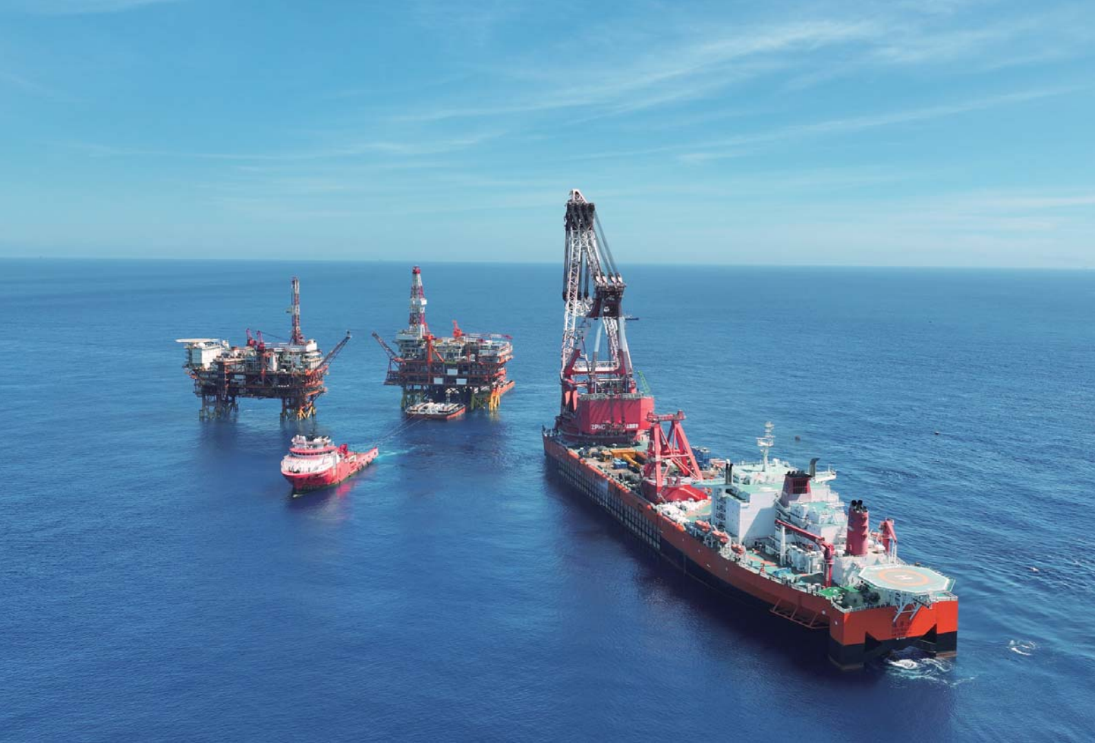
△惠州 25-8 油田综合调整项目 DPPB 平台海上安装
