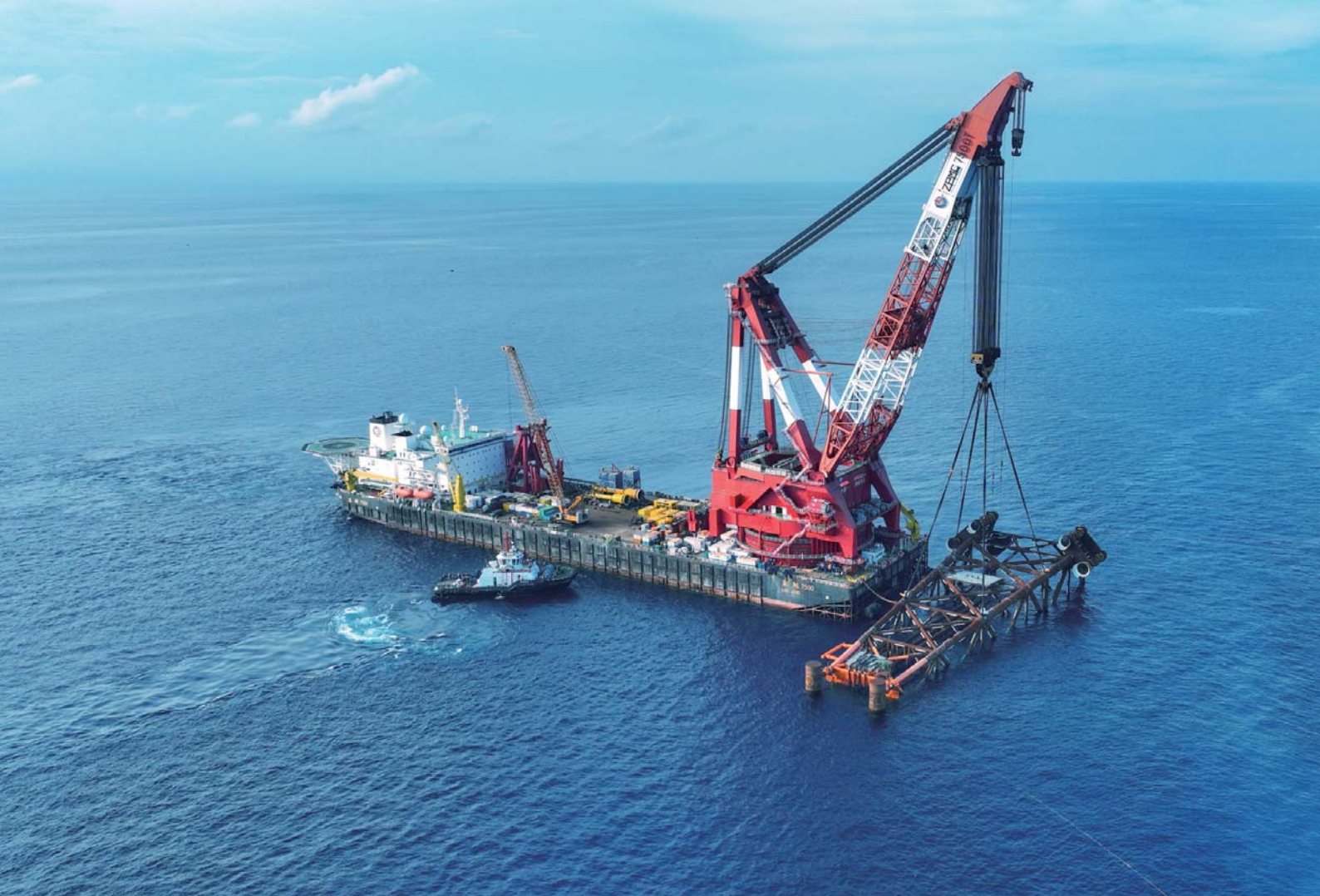
▲西江24区开发项目 24-7导管架顺利下水
